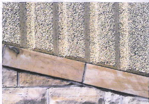
Das haufwerksporige Gefüge des Leichtbetons trägt ebenfalls zur Lärmreduktion bei. Durch die Vergrößerung der Oberfläche kann mehr Schall aufgenommen werden.
