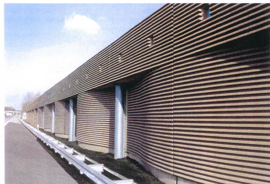
Abbildung 1: Die Oberflächenstruktur von Lärmschutzwänden kann die Lärmabsorption verbessern. Bewährt haben sich Sinusprofilierungen. Fotos: F.C. Nüdling
