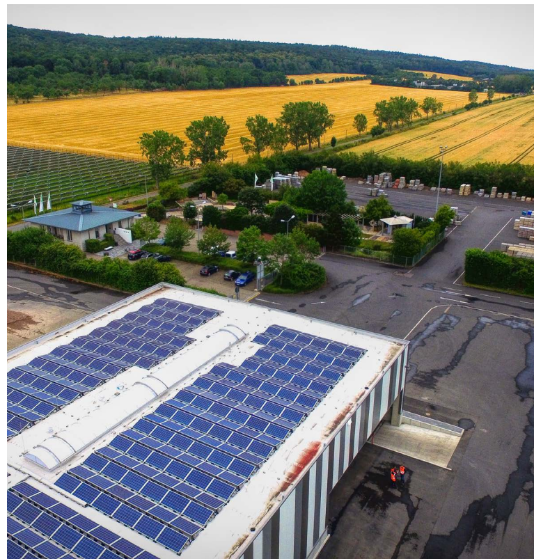
Bild: Photovoltaik-Anlagen Betonwerk Wandersleben
