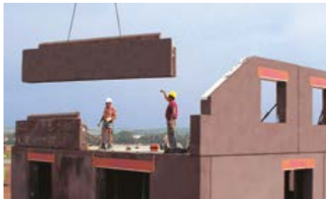
» Montage der fertigen FCN-Klimawände
