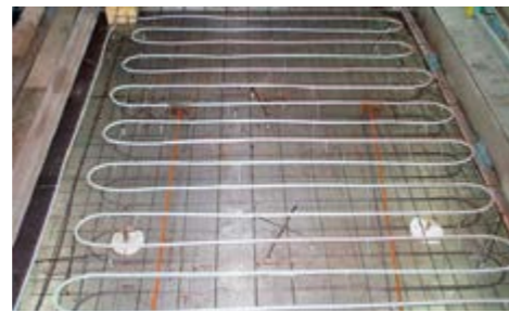
Vorfertigung auf Systemschalungen »
