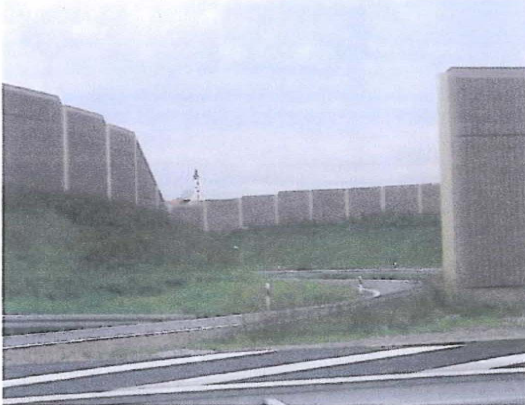
Im Zuge des dreispurigen Ausbaus wurden an der A 3 im Streckenabschnitt Würzburg-Kist die neuen Schallschutzelemente von F.C. Nüdling eingebaut
