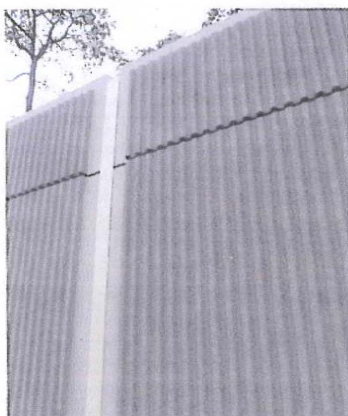
Oberflächen in Rippenstruktur vergrößern die Betonoberfläche und verbessern damit die Schallabsorption
