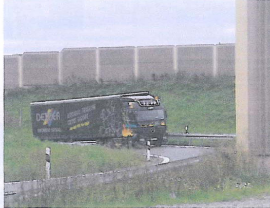
Die Elemente verfügen über Höhen von bis zu 3,75 m und entsprechen der Lärmschutzkategorie „Lärmdämmend und Lärmabsorbierend bzw. Hochabsorbierend“
