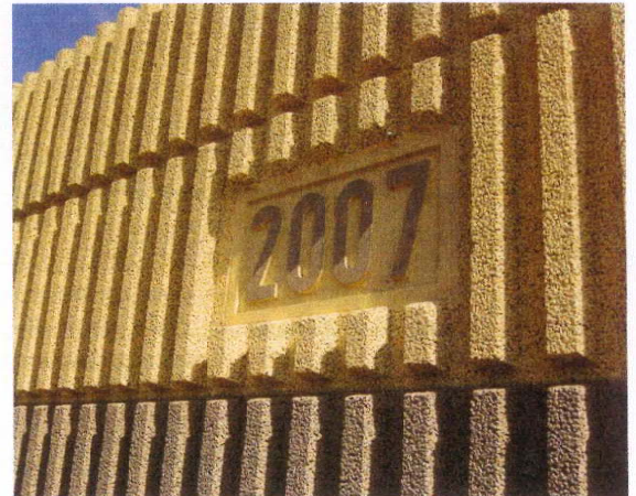
Abbildung 2: Profilierungen lassen sich auch in senkrechter Form gestalten. Zusätzliches Element ist bei diesem Beispiel das in die Struktur integrierte Baujahr
