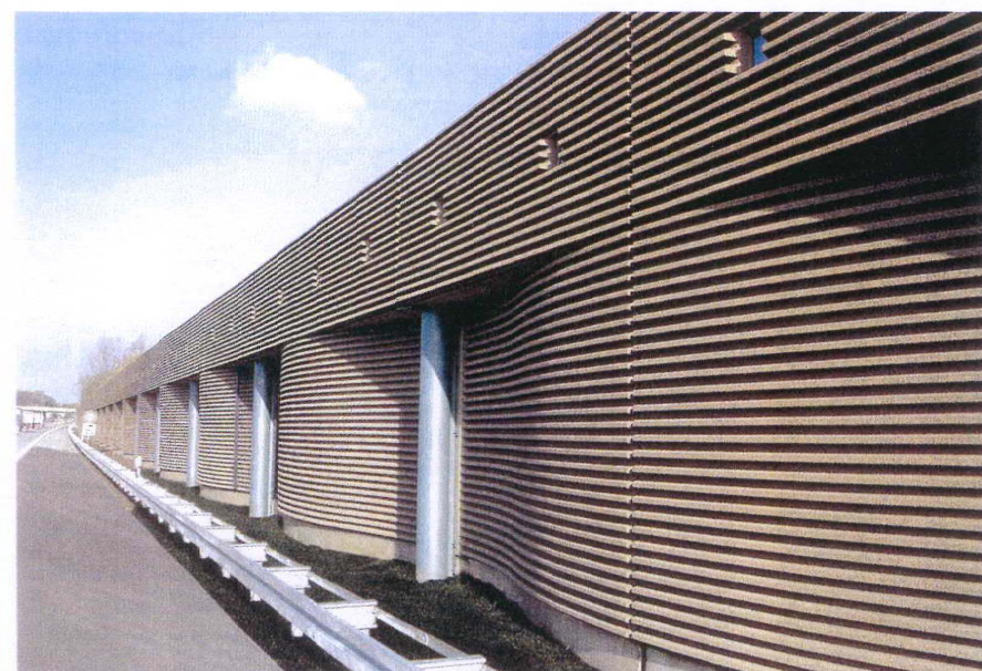
Abbildung 1: Die Oberflächenstruktur von Lärmschutzwänden kann die Lärmabsorption verbessern. Bewährt haben sich Sinusprofilierungen.
