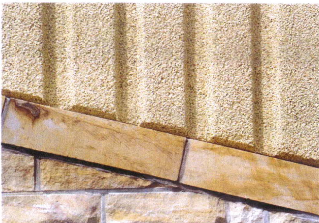
Abbildung 3: Das haufwerksporige Gefüge des Leichtbetons trägt ebenfalls zur Lärmreduktion bei. Durch die Vergrößerung der Oberfläche kann mehr Schall aufgenommen werden
