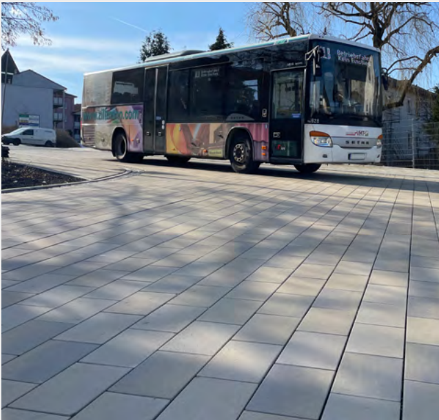
Insbesondere in den Kreuzungsbereichen wirken die Fahrzeuge oft mit besonderen Schub- und Scherkräften auf die Flächen ein. (Bild: SF-Kooperation GmbH Beton-Konzepte)
