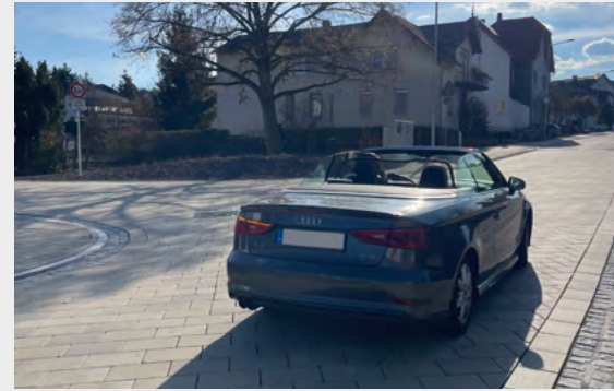
Das hier eingesetzte Betonsteinpflastersystem Primavera® VS5.12 aus dem Hause FCN trägt zur Stabilität der rund 800 m 2 großen gepflasterten Bereiche bei. (Bild: SF-Kooperation GmbH Beton-Konzepte)
