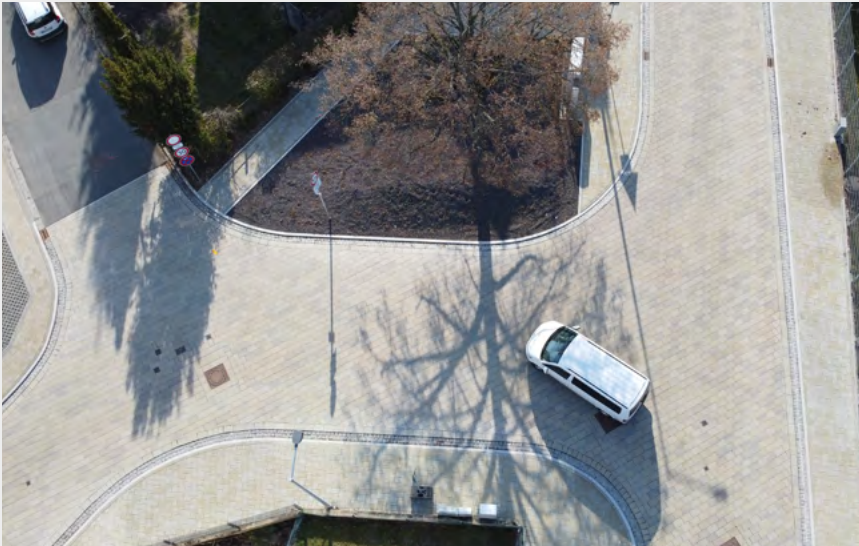
Das VS 5 Pflastersystem weist im Zusammenspiel mit dem Fugen- und Bettungsmaterial ECOPREC® eine dauerhaft stabile Fuge auf. (Bild: SF-Kooperation GmbH Beton-Konzepte)
