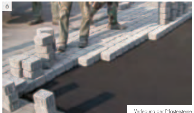
Verlegung der Pflastersteine
