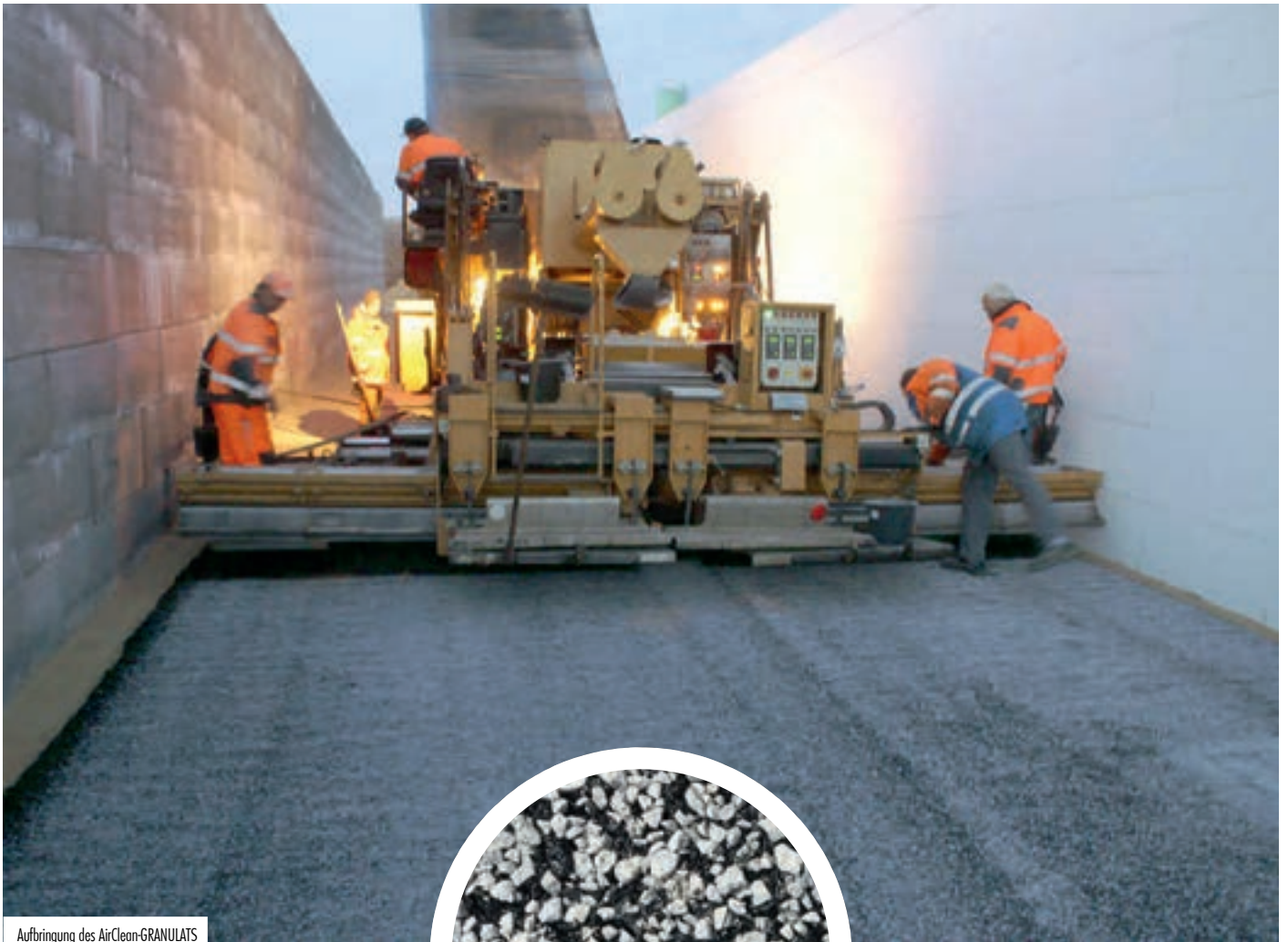
Aufbringung des AirClean-GRANULATS
