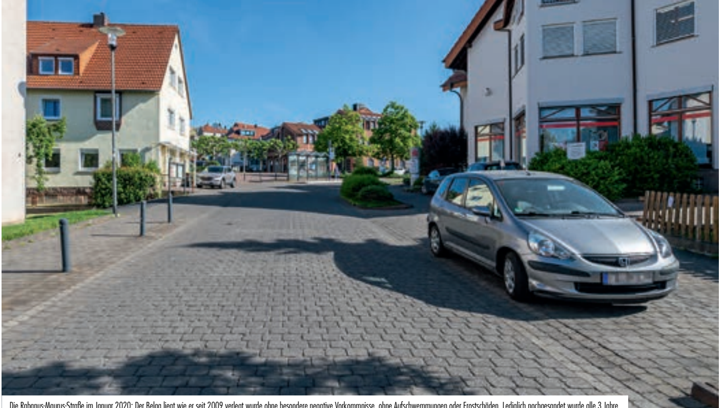
Die Rabanus-Maurus-Straße im Januar 2020: Der Belag liegt wie er seit 2009 verlegt wurde ohne besondere negative Vorkommnisse, ohne Aufschwemmungen oder Frostschäden. Lediglich nachgesandet wurde alle 3 Jahre.
