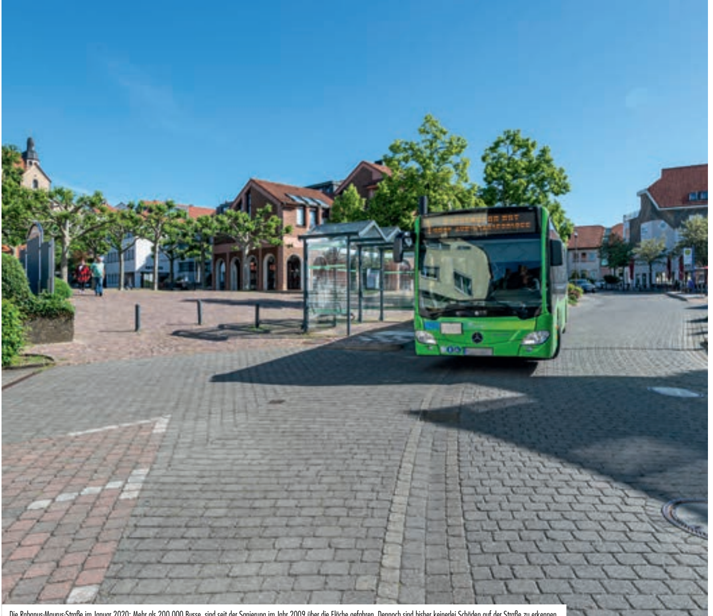
Die Rabanus-Maurus-Straße im Januar 2020: Mehr als 200.000 Busse, sind seit der Sanierung im Jahr 2009 über die Fläche gefahren. Dennoch sind bisher keinerlei Schäden auf der Straße zu erkennen.
