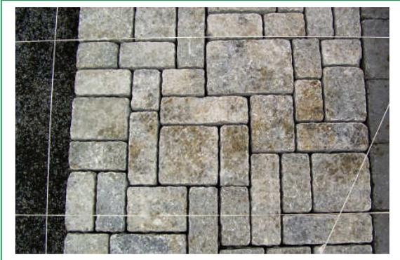
Beginnen Sie mit dem Verlegen der Steine an einer Seite der Randeinfassung. Bereits nach wenigen verlegten Steinzeilen prüfen Sie die Rechtwinkligkeit und den korrekten Fugenverlauf. Vermeiden Sie bei einer unregelmäßigen Verlegung einzelne Fugen, die länger als 80 cm sind.
