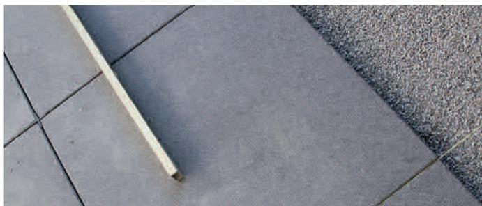
Die Verlegung mit PlattenFix-Lagern ist nur bei zweischichtigen Terrassenplatten möglich. Bei Terrassenplatten ab dem Format 40 x 60 empfehlen wir außerdem zusätzliche Auflagepunkte im Bereich des Plattenmittelpunktes.
