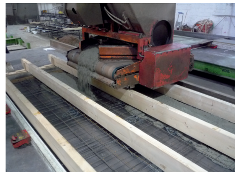
Einbringen von Beton
