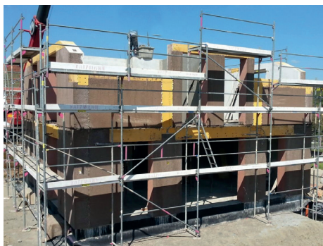
Montage Obergeschoss
