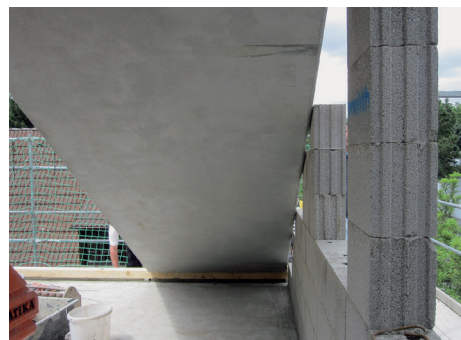
Anschlussdetail Wand/Mauerwerk
