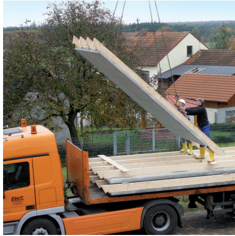
1. Anlieferung der vorgefertigten Massivdachelemente
