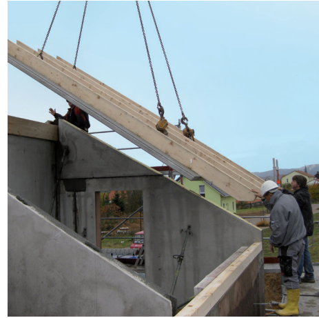
2. Aufbringen der kompletten Systemteile
