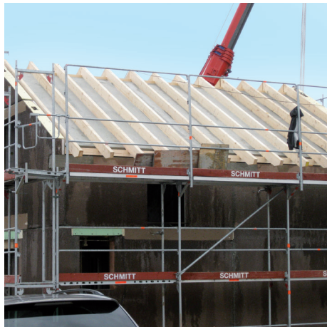
3. Endmontage und Fertigstellung
