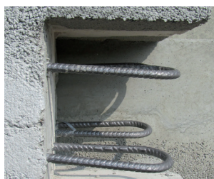
Ringankeranschluss
