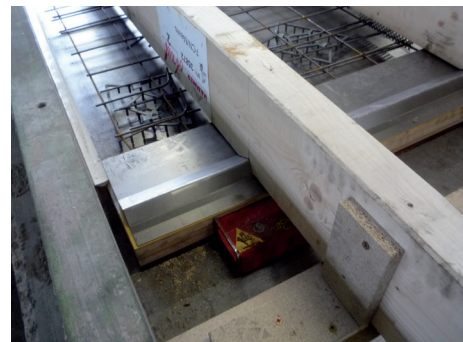
Fixierung der Sparren auf der Schalung
