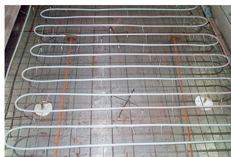
Vorfertigung auf Systemschalungen
