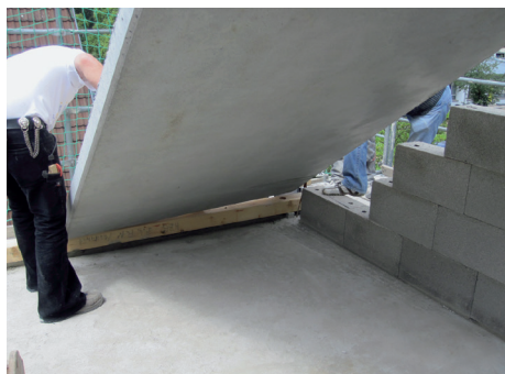
Anschlussdetail Decke
